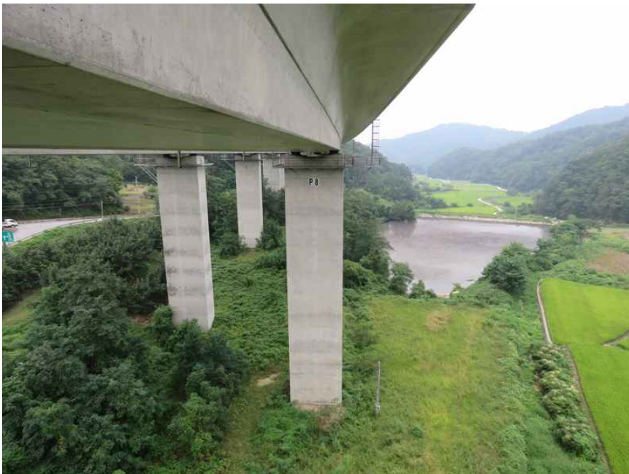
교각 전경 (P8)
