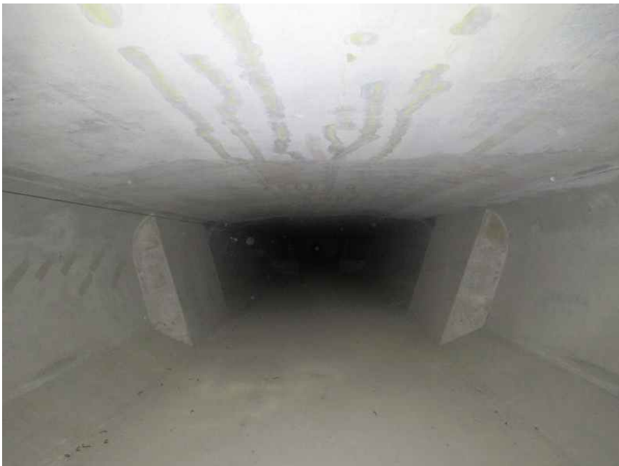
PSC Box Girder 내부전경
